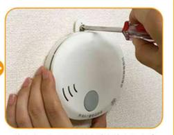
途中までねじ込んだネジを締め込めば 取り付け完了です。
